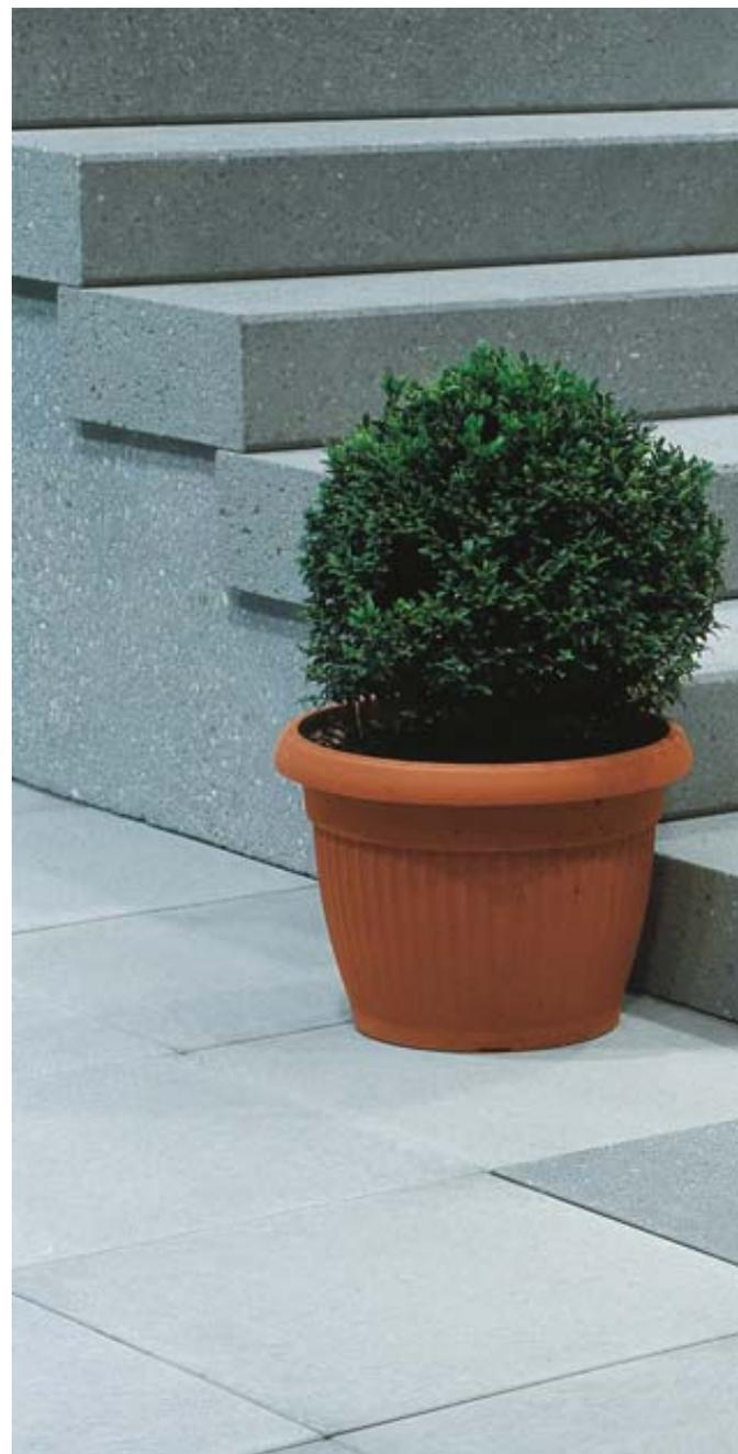
**Feingestrahlte Blockstufen aus Rundkies (alle Sichtseiten gestrahlt)**
