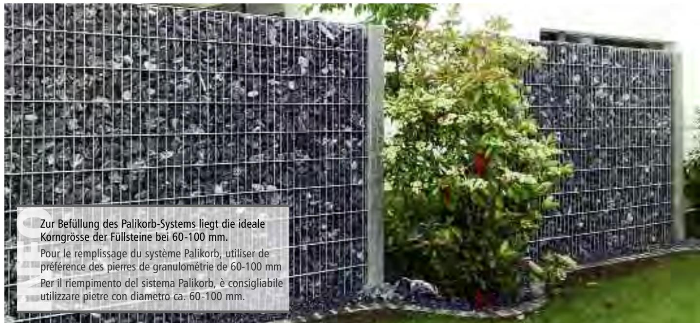
Zur Befüllung des Palikorb-Systems liegt die ideale Korngrösse der Füllsteine bei 60-100 mm.
